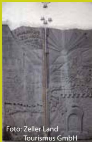
Die Hochwasserschutzmauer am Moselufer wurde 1989 zum Schutz der Altstadt gebaut. Erst bei einem Pegelstand von 8,45 Meter (in Trier) überflutet die Mosel die Stadt. (Pegelstand normal: 2,50 Meter - 2,70 Meter). 1993 erreichte die Mosel einen Pegelstand von 11,30 Meter und zählte somit zu den höchsten Hochwasserfluten der letzten Jahrhunderte.
